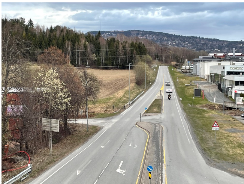
Griniveien ved Jaktlia, sett mot øst
