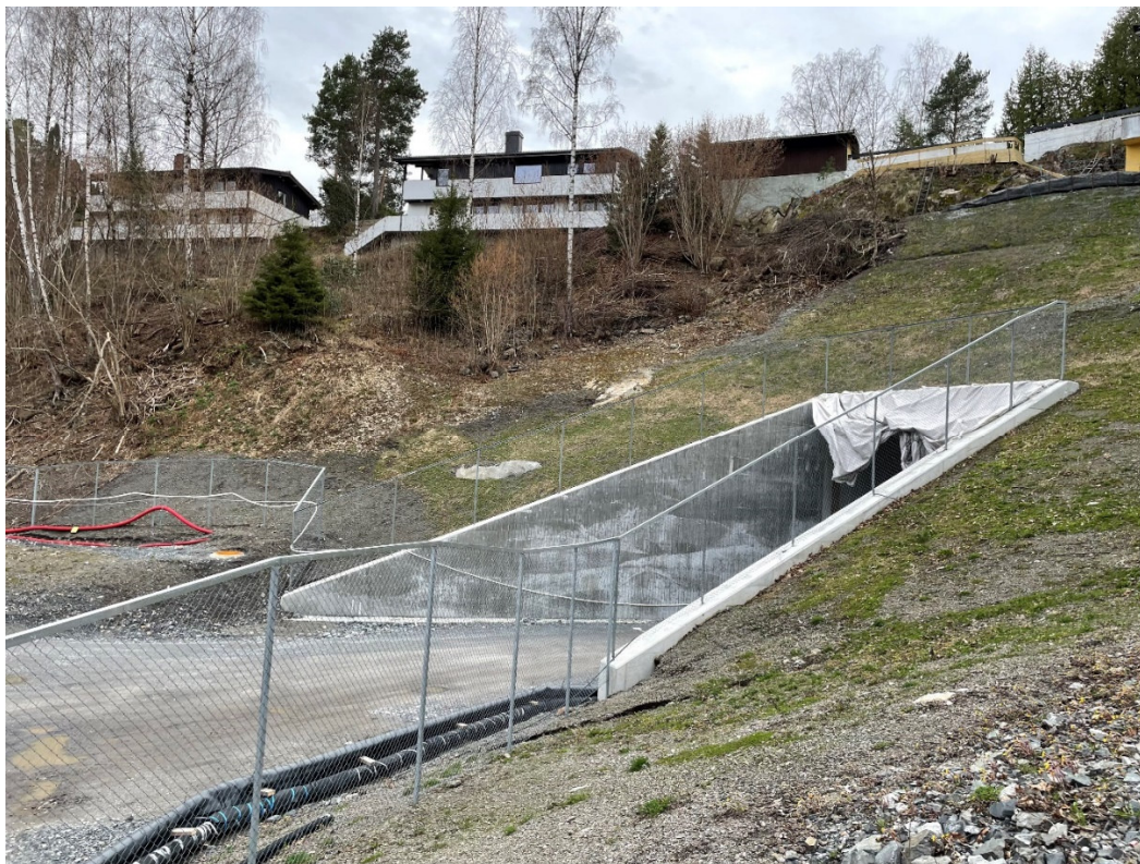
Etablert tunnelåpning for anleggsdrift i friområde ved Makrellbekken/Smestad
